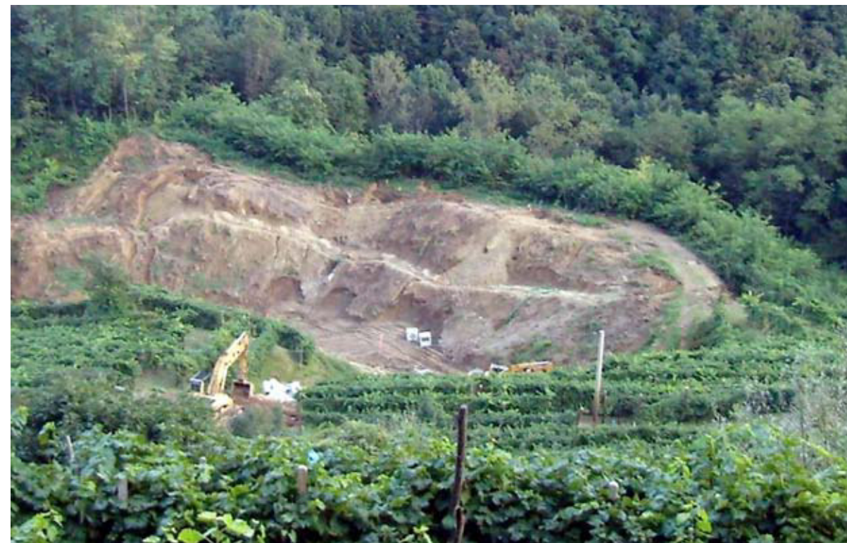
Uno sbancamento per ampliare le vigne del Prosecco a Miane nel 2010
